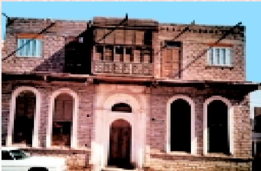
البناء بالطوب (الآجر) مع بناء روشان فوق المدخل، وشيش على بقية النوافذ وحلوق جصية حول الأبواب والنوافذ
